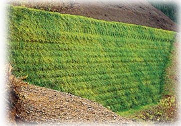
例: 補強土壁工
