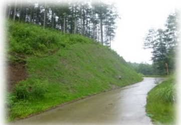
例: のり面緑化工
