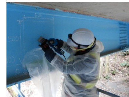
塗膜の部分剥離
