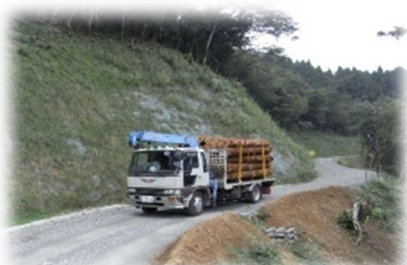
基幹となる林道
