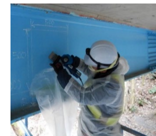
塗膜の部分剥離
