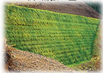
例：補強土壁工
