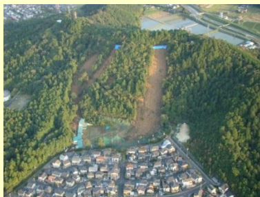
山腹崩壊の発生状況
