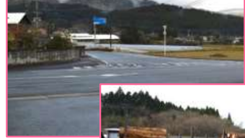
基幹農林道1工区起点(奥が基幹農林道)
