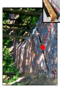
排水施設の整備
