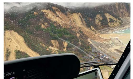
1/21 大規模崩壊地の確認
