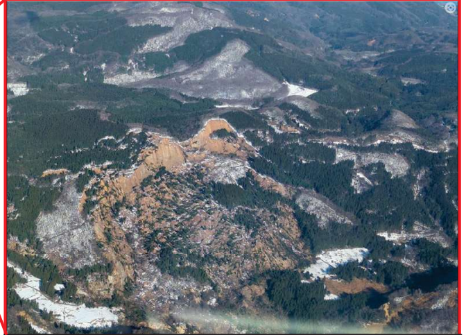
大規模な山腹崩壊地（輪島市・珠洲市）
