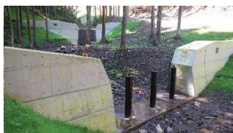
流木捕捉式治山ダムの設置
