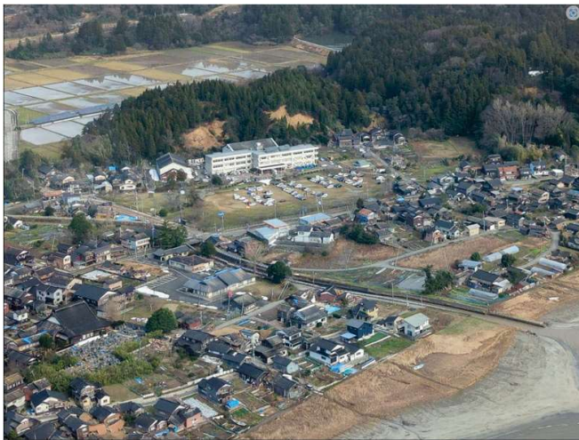
学校の裏山崩壊（珠洲市）
