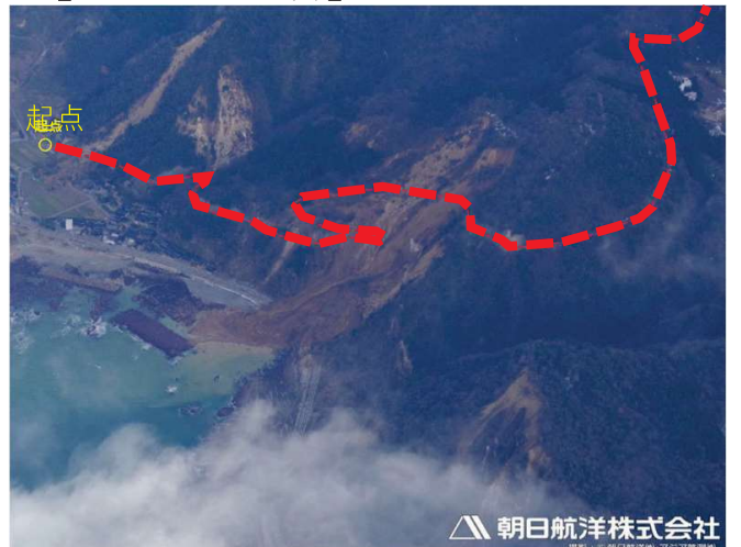
山腹崩壊による林道の崩落（珠洲市）
