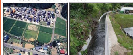
ほ場整備による農業生産性の向上と秩序ある土地利用の推進 老朽化した用水路の整備・更新
