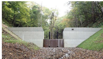
流木捕捉式治山ダムの設置
