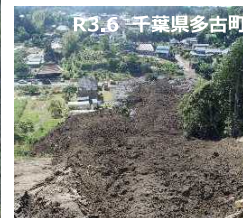
R3.6 千葉県多古町 廃棄された土石の崩落 軽傷者1名、県道通行止め
