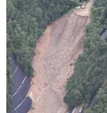
廃棄された土石の崩落 死者1名、重傷者1名、 住宅被害1棟
