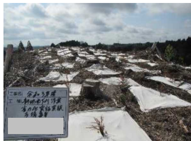
〈防草シート設置状況〉
