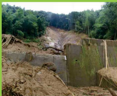
治山施設の復旧
