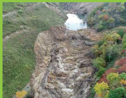
林道施設の復旧
