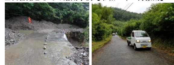
林道渡沢鳥居峠線(応急対策の実施状況)【長野県】
