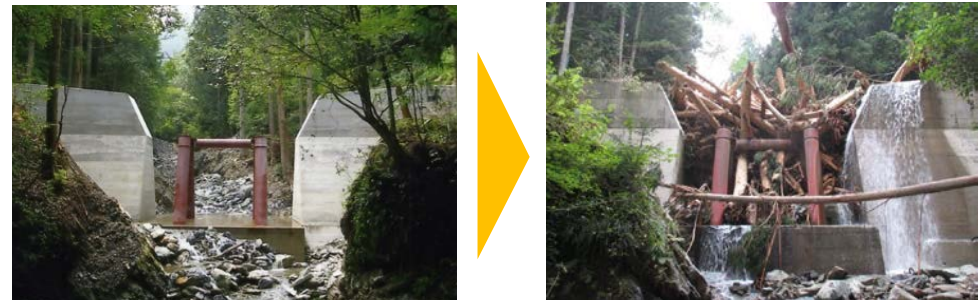
流木捕捉式治山ダムの整備
