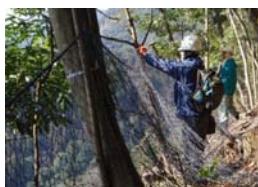
防護柵の整備
