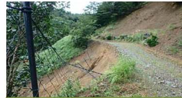
被災した森林作業道の復旧
