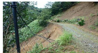
被災した森林作業道の復旧
