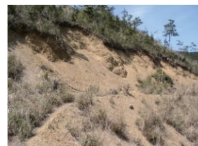
切り取り法面の崩壊
