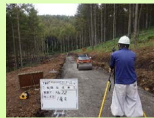
自動追尾型トータルステーションを利用した起工測量
