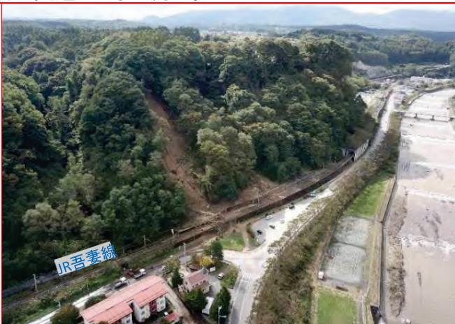
【群馬県嬬恋村芦生田川原(つまごいむらあししょうだかわはら)】 山腹崩壊が4箇所にわたり発生し、土砂及び樹木が鉄道(JR吾妻線)と国道144号に流出。
