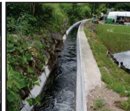
老朽化した用水路の整備・更新
