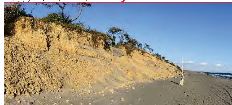
【静岡県磐田市鮫島(いわたしさめじま)】 台風19号による波浪の影響で防潮堤(土堤)が侵食。
