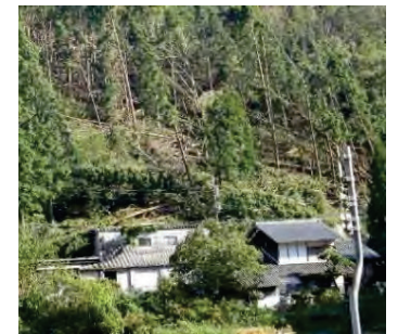
台風による民家裏の倒木被害（京都府）
