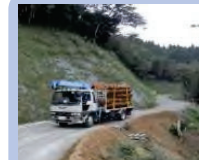
幹線となる道の整備
