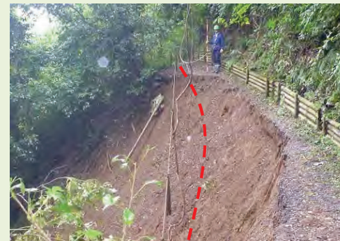
【崩落により寸断された歩道】 (破線は損壊前のイメージ) 試験調査地へのアクセス道であり、一般来園者も利用する歩道が崩落により寸断。
