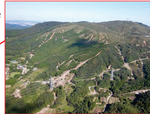
【神奈川県相模原市緑区牧野(まぎの)】 土砂流出に伴い人家1戸が損壊、市道が被災。2名死亡。
