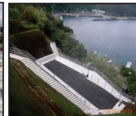
漁村における津波避難対策のための漁港整備（避難地、避難路の整備）
