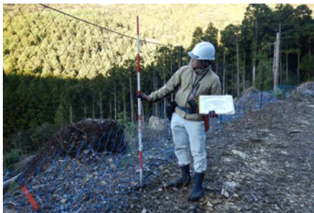
ネット・支柱設置高の確認（R5.11.13撮影）※提供写真
