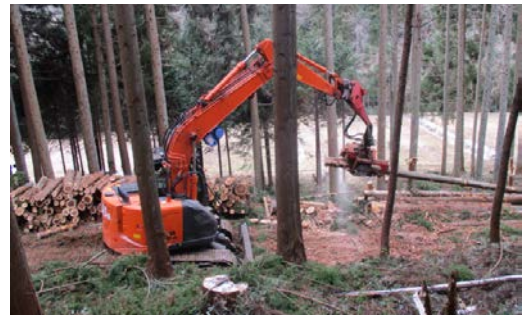
施工中写真：造材作業中（プロセッサ） （R4.1.27撮影）※提供写真 方法によって単価が異なるため、写真提出必須
