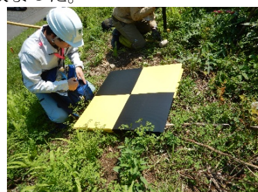
対空標識の設置状況
