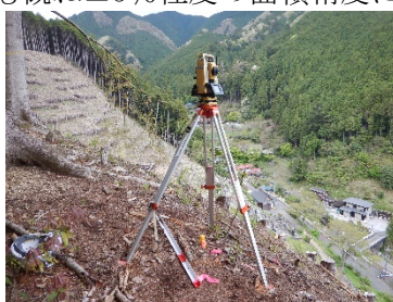
トータルステーション測量
