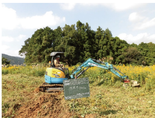
重機による下刈り (令和元(2019)年 11 月上旬)
