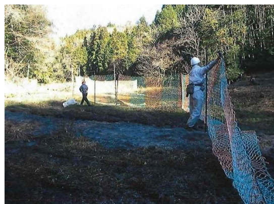
獣害防止柵の設置
