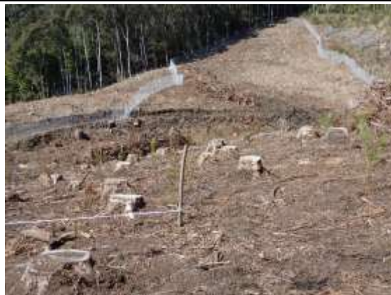
シカ柵の敷設
