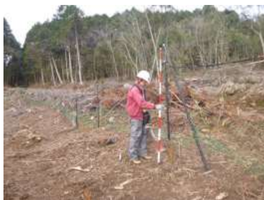
シカネットの設置
