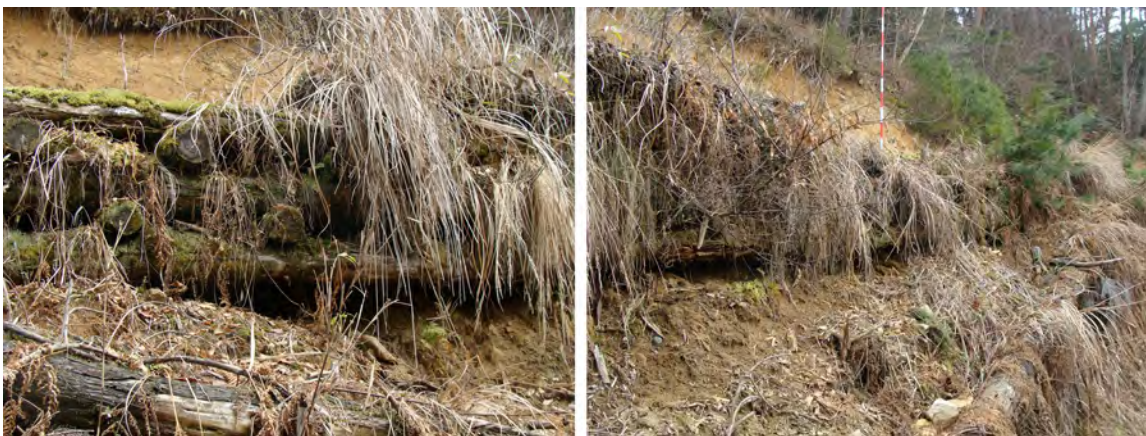
写真 6-4 丸太積工の状況
