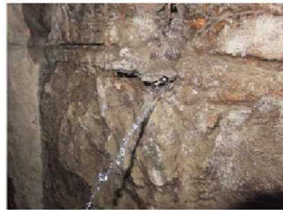
付写真-1.4.3 漏水（噴出）している例
