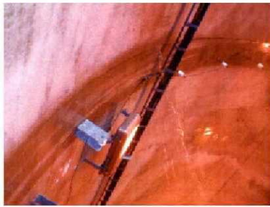
付写真-1.4.3 漏水（噴出）している例
