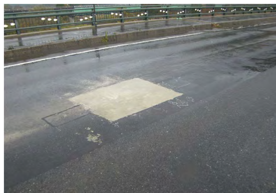
舗装損傷部の補修状況 (床版上鉄筋部までコンクリート補修)
