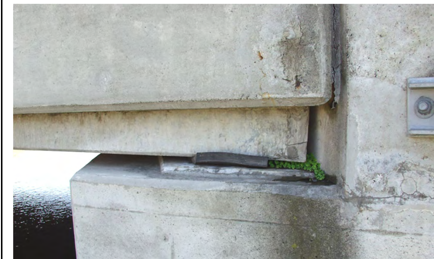
写真番号 15.1.5 説明 ゴム支承の変位追従機能と荷重支持機能が損なわれている状態の例
