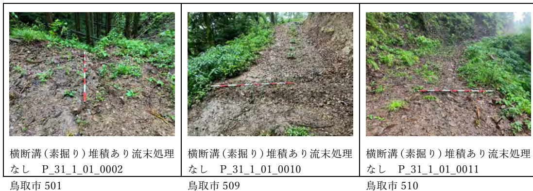
図 2.1-136 排水施設の設置状況
