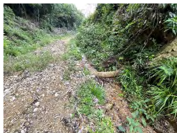
側溝／森林作業道
