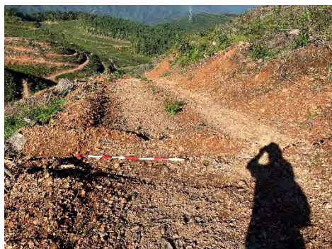
横断溝（素掘り）の土盛りの設置例
