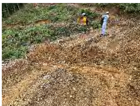
横断溝（素掘り）土盛りの設置例
