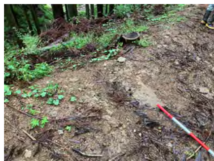
横断溝の流末処理なし
