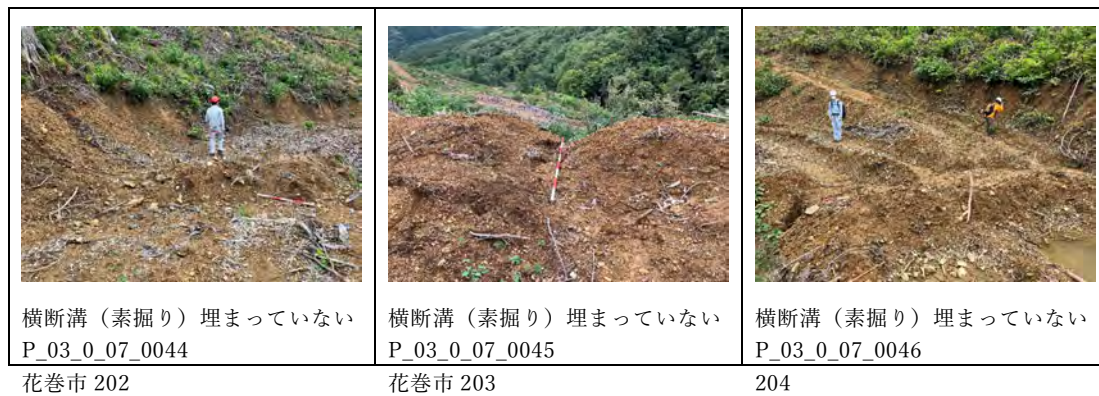
図 2.1-33 排水施設の設置状況
