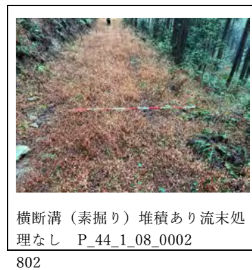
図 2.1-245 排水施設の設置状況
