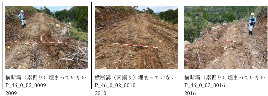
図 2.1-337 排水施設の設置状況
