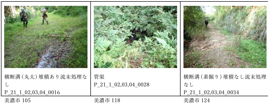
図 2.1-113 排水施設の設置状況
