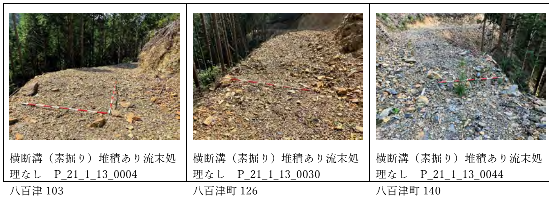
図 2.1-123 排水施設の設置状況
