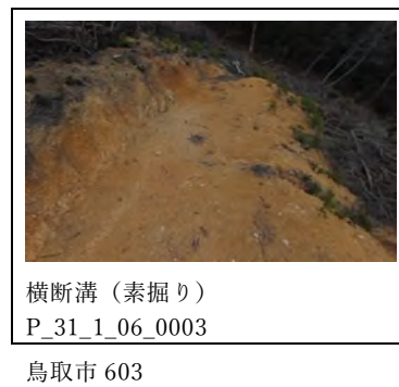
図 2.1-156 排水施設の設置状況
