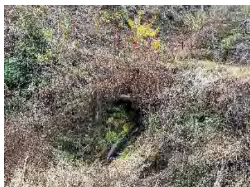
管渠／森林作業道
