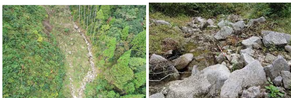
図 2.2-30 溪流沿いに作設した作業道が豪雨時の土石流で崩壊した例
