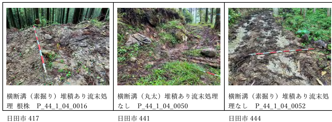
図 2.1-225 排水施設の設置状況
