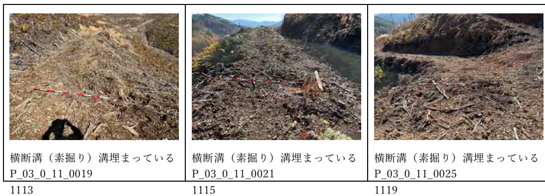
図 2.1-48 排水施設の設置状況
