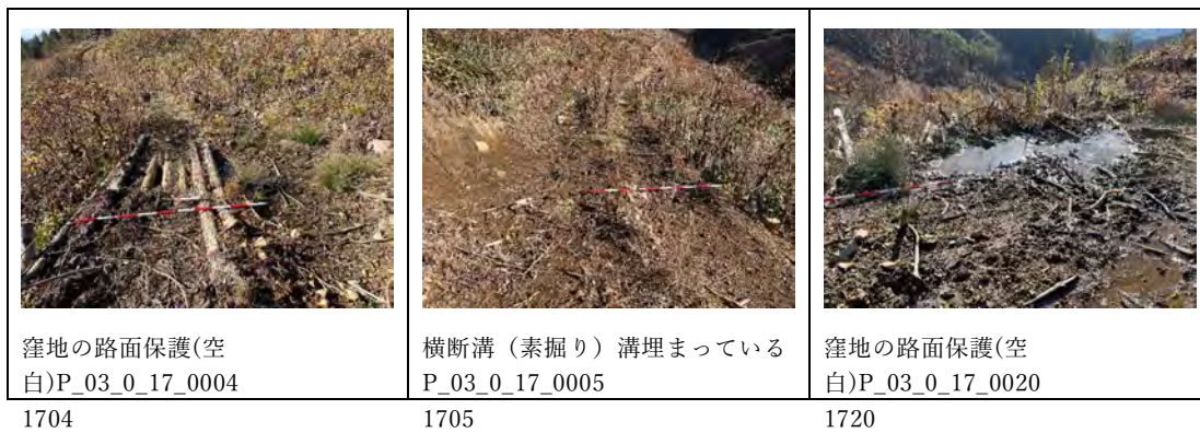
図 2.1-73 排水施設の設置状況
