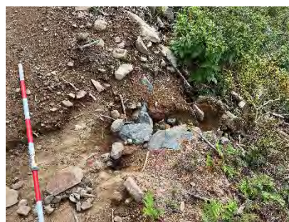
横断溝の流末（石）/集材路
