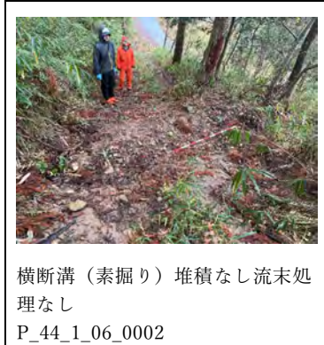
図 2.1-235 排水施設の設置状況
