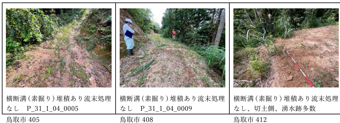
図 2.1-146 排水施設の設置状況
