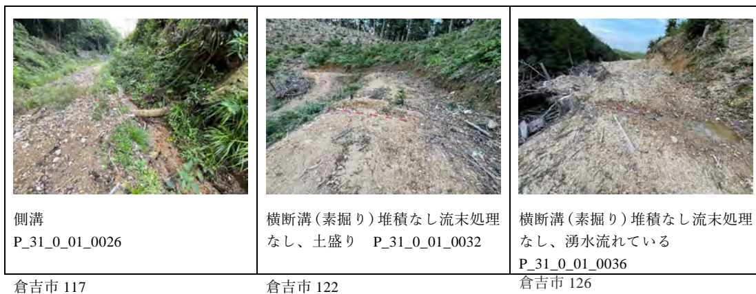
図 2.1-165 排水施設の設置状況
