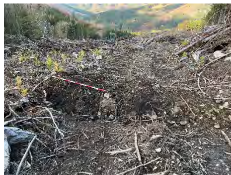
横断溝（素掘り）土盛りの設置例
