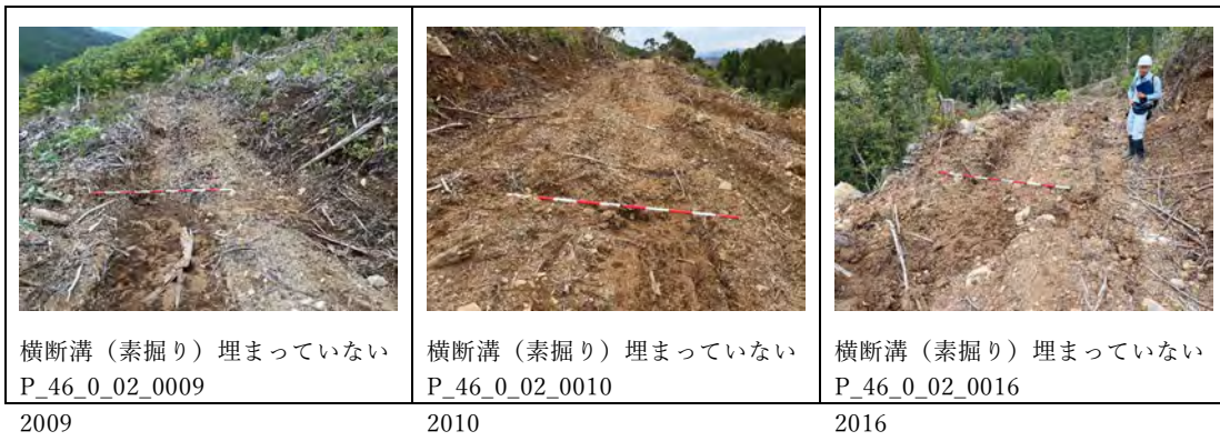
図 2.1-332 排水施設の設置状況
