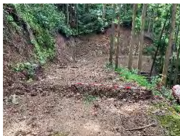
横断溝（素掘り）／森林作業道
