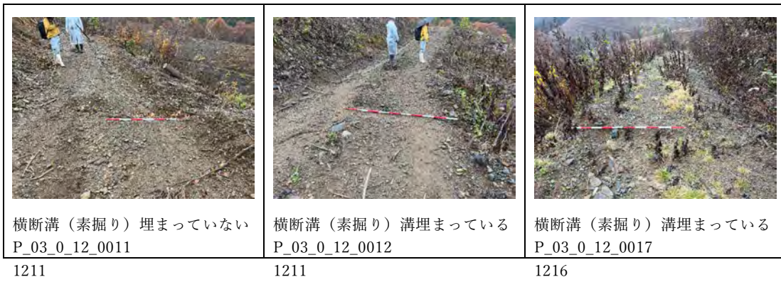
図 2.1-53 排水施設の設置状況
