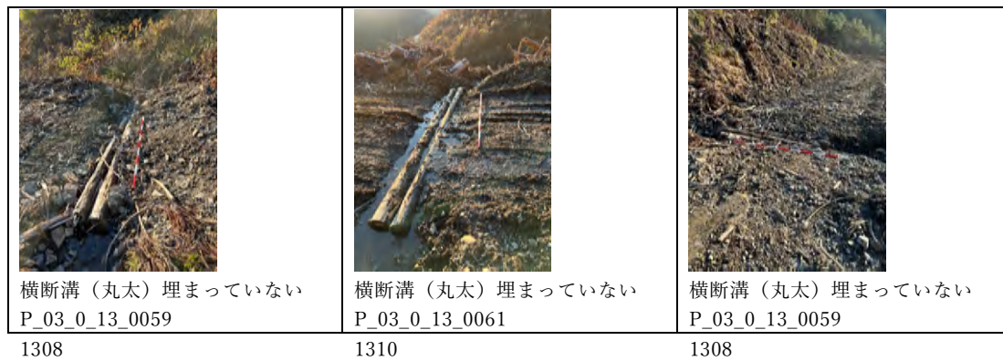
図 2.1-58 排水施設の設置状況
