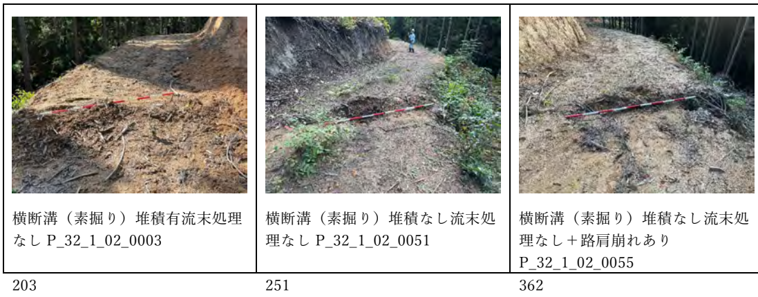
図 2.1-178 排水施設の設置状況
