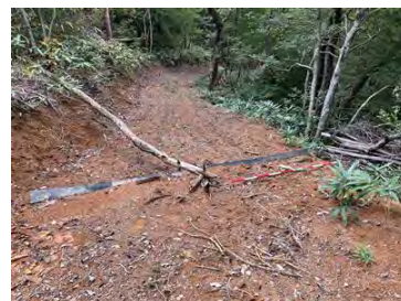
横断溝（ゴム板）／森林作業道
