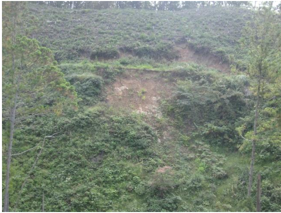
写真-2.6 森林作業道下の崩壊 (支溪左岸斜面)
