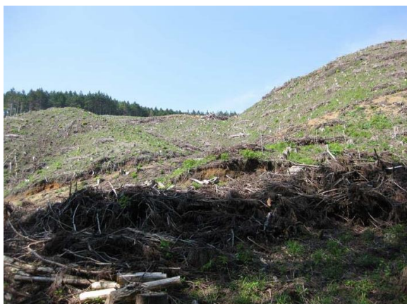
写真-2.54 森林作業道全景
