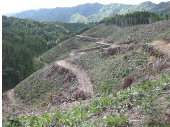
写真-2.11 切土高が一定で地形なりに上手く作設されている森林作業道
