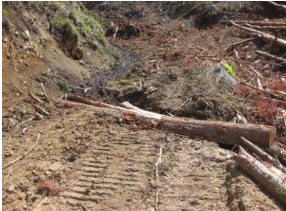
写真-2.45 森林作業道の急勾配箇所、路体維持のため丸太横断工が設置されている。
