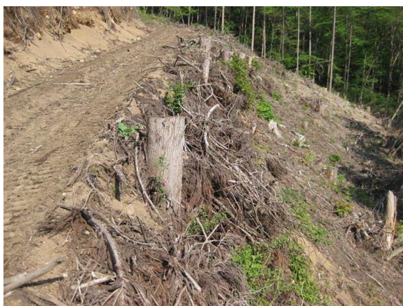
写真-2.56 森林作業道の盛り留め箇所は切株を高くし、杭代わりに用いている。
