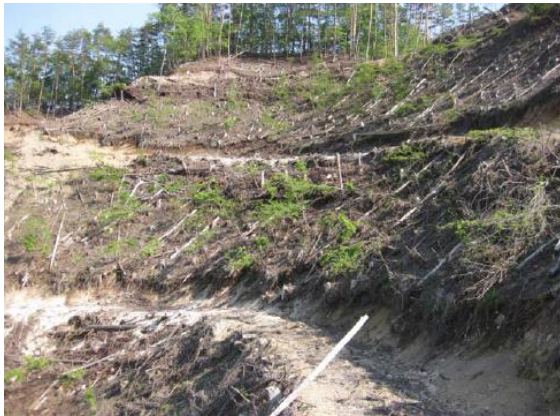
写真-2.40 集材路の設置間隔が、10m未満
