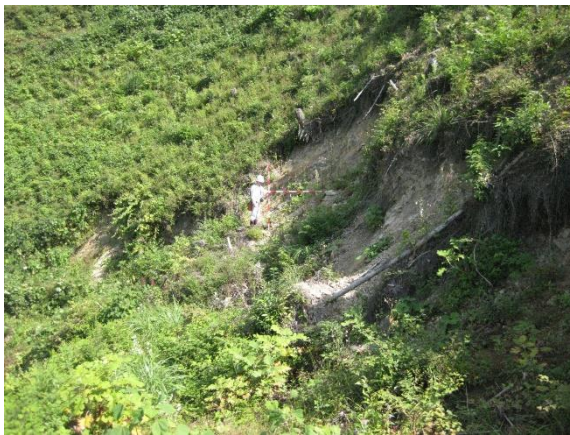
写真-2.8 森林作業道上の崩壊地 (本流上流)
