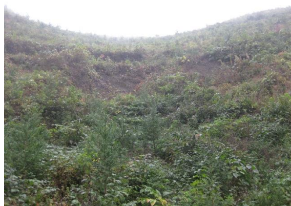
写真-2.21 森林作業道下の崩壊地
