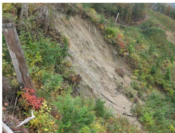
写真-2.16 森林作業道下の崩壊地
