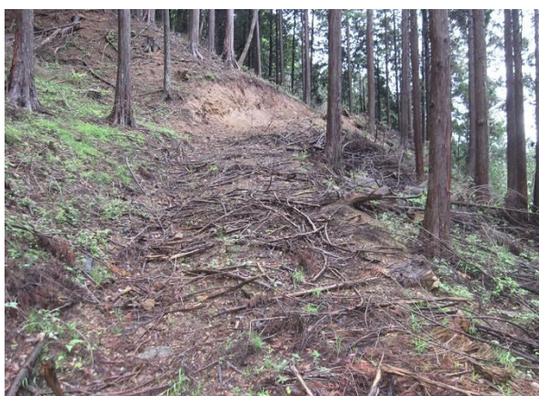
写真-2.74 30%勾配区間での路面枝条敷設 （塩那）
