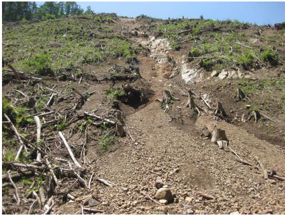
写真-2.28 最上段の森林作業道から 表層崩壊が発生している。
