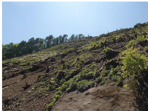
写真-2.27 地質は中世代ジュラ紀の堆積岩類で、急峻な地形となっている。
