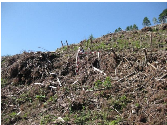
写真-2.12 森林作業道谷側の枝条処理 (伐採木を活用した杭木を設置)
