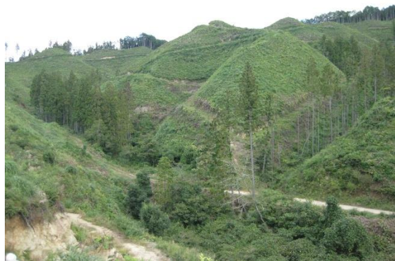
写真-2.5 本流と支溪の間の尾根に取り付く森林作業道（勾配23%～28%）
