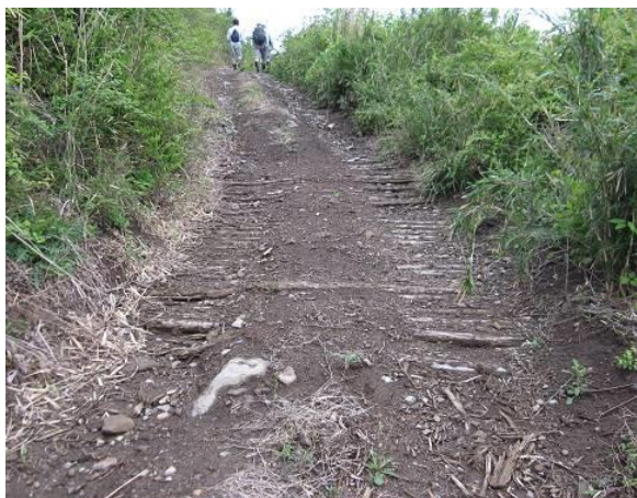
写真-2.68 急勾配区間での丸太敷設路面（塩那）
