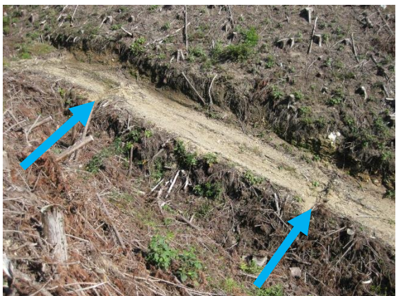
写真-2.14 森林作業道の素掘り横断溝
