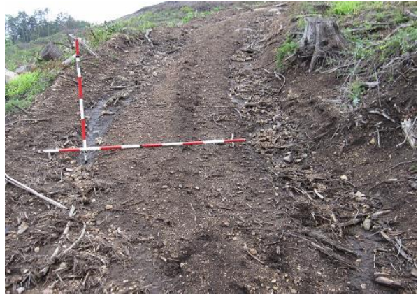
写真-2.66 枝条散布で侵食防止を図った路面
