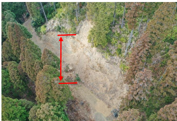
写真-5.2 最大切土高10m (H-3) の状況
