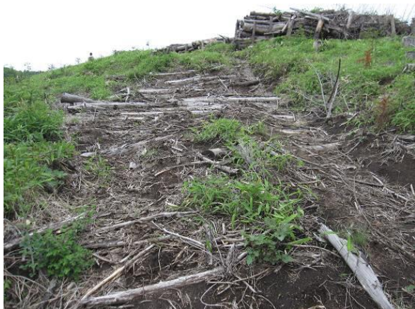
写真-2.58 20%以上の急勾配区間の丸太及び枝条の敷設状況。
