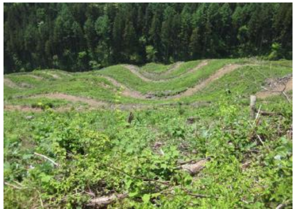
写真-2.49 急峻な窪地に4段もの集材路が開設されているが、崩壊等は確認されない。
