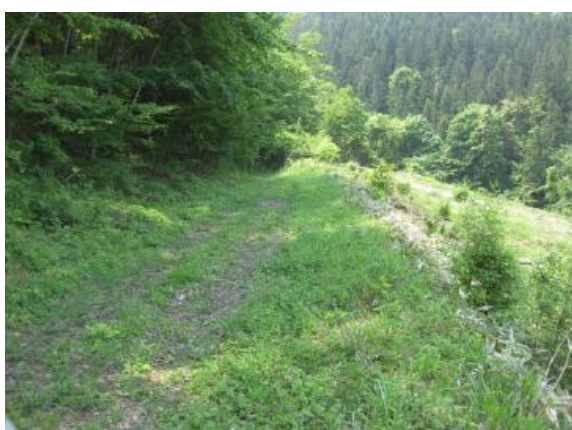
写真-2.51 森林作業道は切取法面が低く、植生が侵入して安定している
