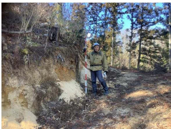
写真-5.4 切土高 2mの箇所
