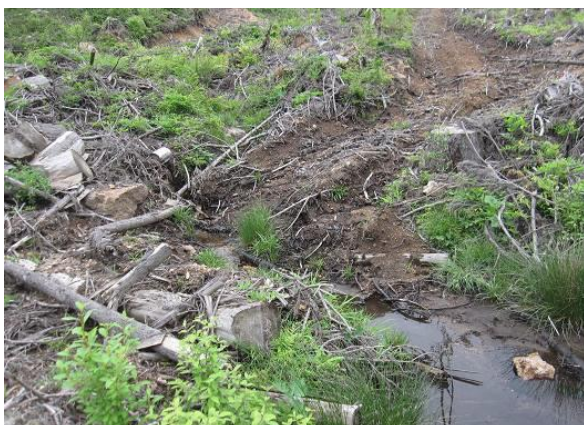
写真-2.63 丸太敷設による横断排水 フォワード等の走行には支障がない。
