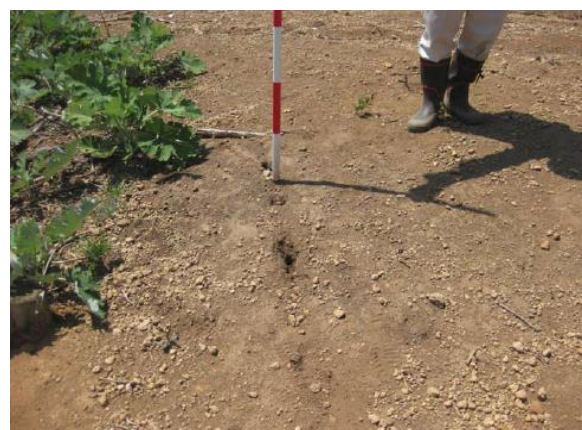
写真-2.33 森林作業道の路面が侵食され、写真-2.34 森林作業道の路肩に発生した亀裂土砂流出が確認される。
