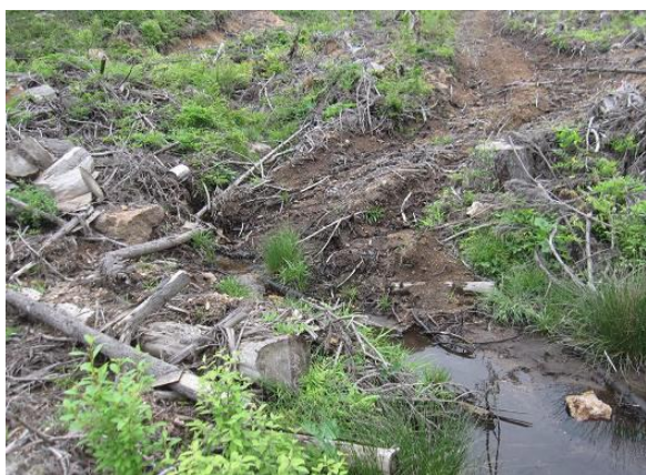
写真-2.72 丸太敷設による横断排水（塩那） フォワード等の走行には支障がない。
