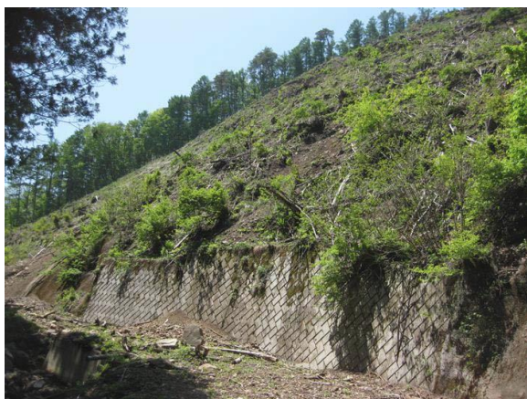
写真-2.26 山脚部のブロック積土留工
