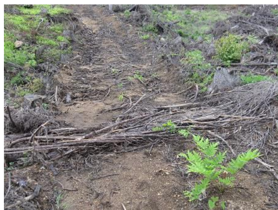
写真-2.73 丸太と枝条敷設の横断工（塩那）
