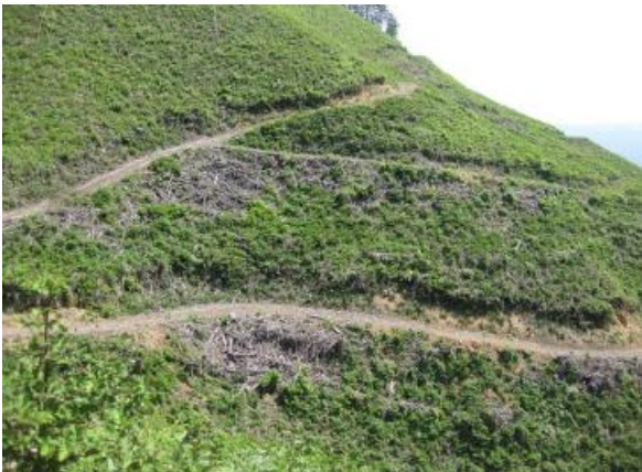
写真-2.48 集材路はほぼ水平に開設されている。切取高が低いため土砂流出が少なく、植生も侵入しつつある。
