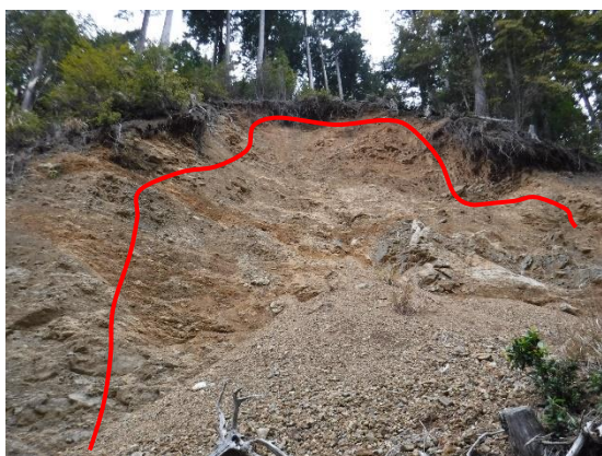
写真-5.1 崩壊と土砂の状況 粘着力のない砂礫が主体
