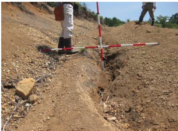
写真-2.33 森林作業道の路面が侵食され、写真-2.34 森林作業道の路肩に発生した亀裂土砂流出が確認される。
