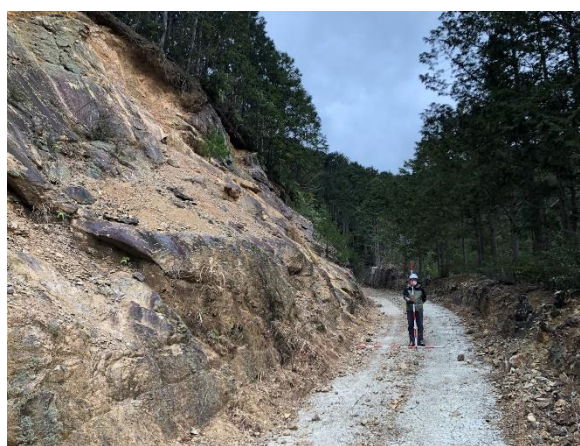
写真-5.5 切土高 15mの箇所
