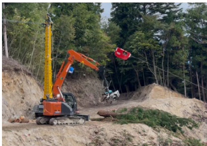
集材：タワーヤードによる作業
