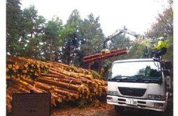
写真-10 トラックへの積込状況
