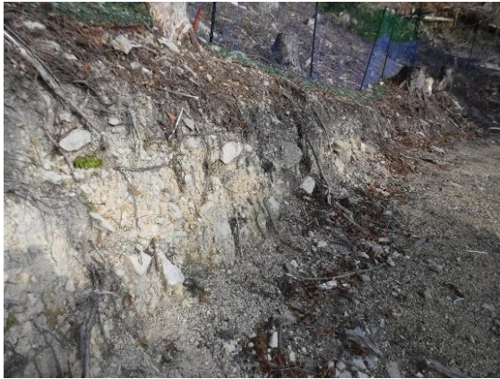
写真-3.131 森林作業道切土のり面
