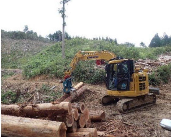
写真-3.5 作業場所
