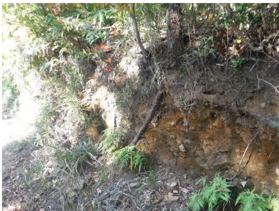
写真-3.99 土場 1 の切土のり面
