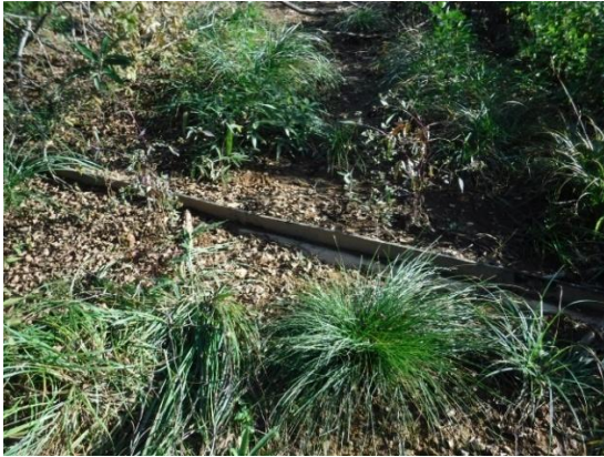
写真-3.95 森林作業道の取付口の路面排水工
