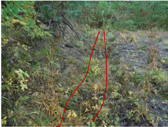
写真-3.39 土場の排水（土側溝）
