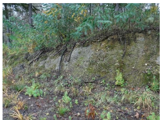
写真-3.38 土場の切土のり面
