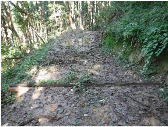
写真-3.78 森林作業道の取付口路面 排水工
