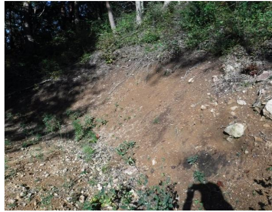
写真-3.86 土場 2 の切土の状況
