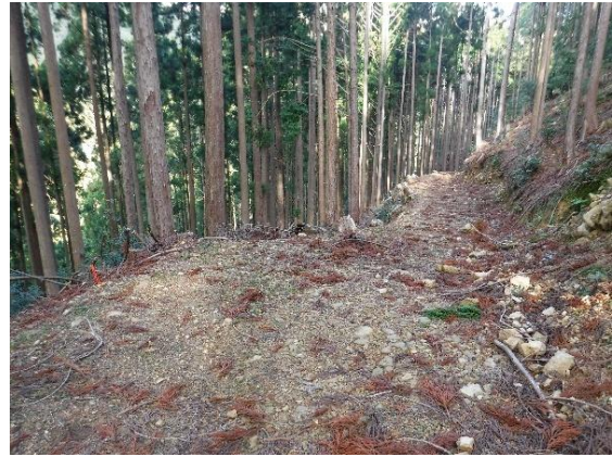
写真-3.124 土場の盛土のり面
