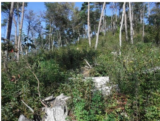
写真-3.91 作業場所 2
