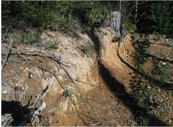
写真-3.89 土場 3 の切土の状況
