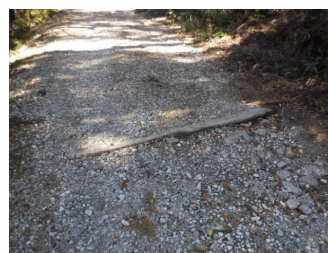
木製路面排水工
