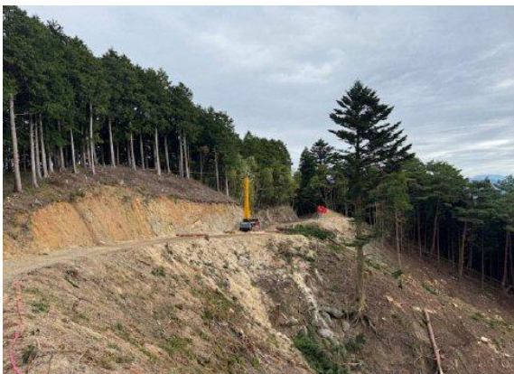
写真-3.110 作業場所 1
