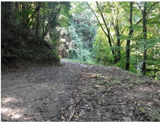
写真-3.76 作業場所 3
