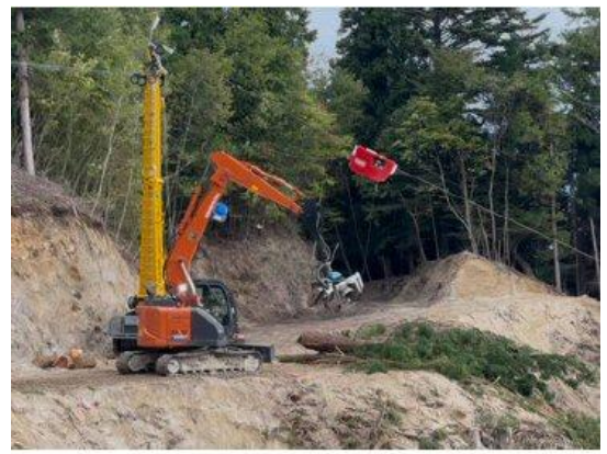
写真-3.111 作業場所 1
