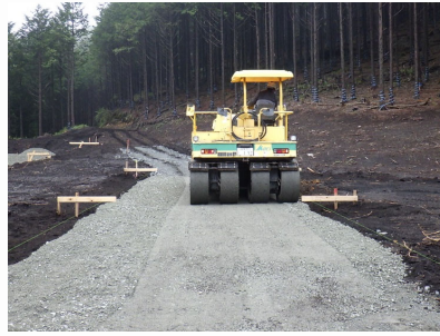
路盤工の施工状況
