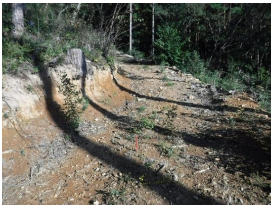
写真-3.93 森林作業道の取付口 2
