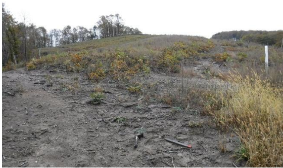
写真-3.41 作業場所
