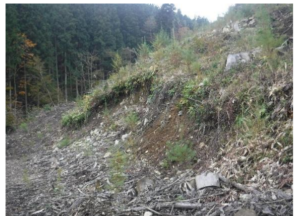
写真-3.48 土場 1 の切土のり面 (粘性土)
