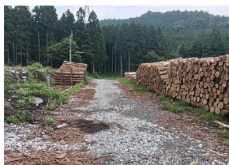
トラック進入路の路盤工
