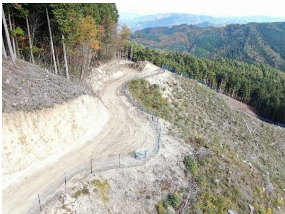
写真-3.112 作業場所 1
