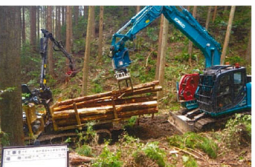
写真-8 フォワーダへの積込状況
