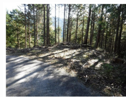
写真-4 作業場所3
