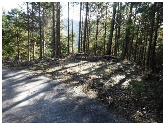
写真-3.104 作業場所 4
