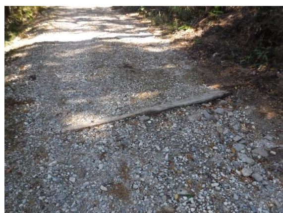
写真-3.106 森林作業道の取付口の敷砂利と横断排水
