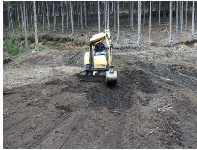
土場施工の状況
