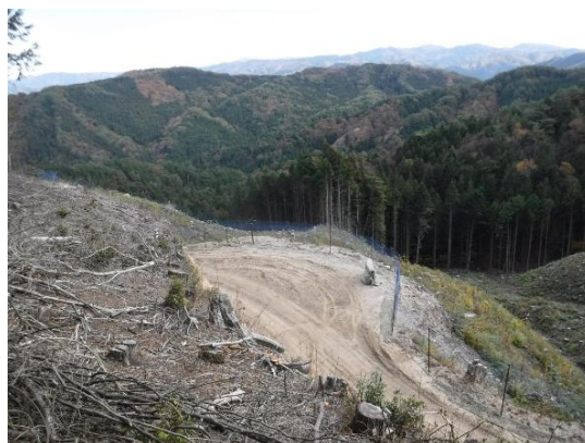
写真-3.113 作業場所 1
