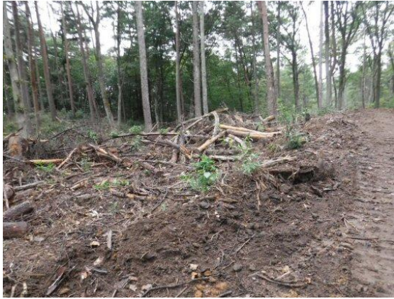
写真-3.67 作業場所 1
