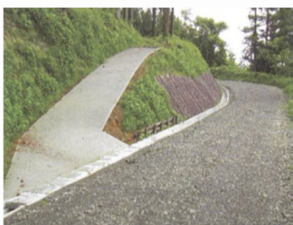
コンクリート路面工
