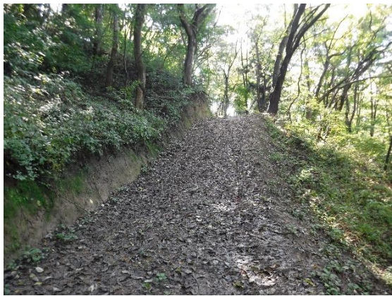
写真-3.77 森林作業道の取付口 (敷き砂利)
