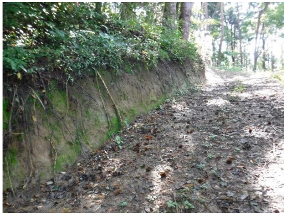
写真-3.79 森林作業道の取付口 の切土状況
