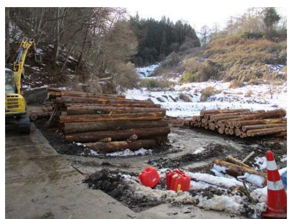
写真-3.73 土場の鉄板敷設の状況
