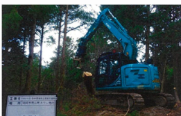
写真-6 スイングヤーダの集材状況
