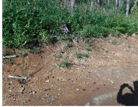
写真-3.84 土場 1 の切土の状況
