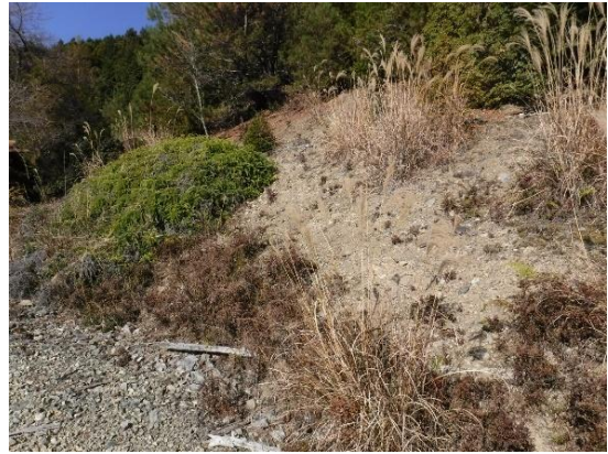
写真-3.139 土場の切土
