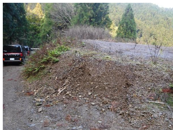
写真-3.122 土場の盛土のり面
