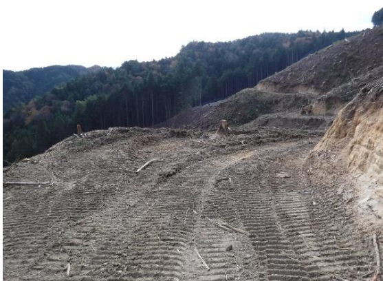
写真-3.114 作業場所 2
