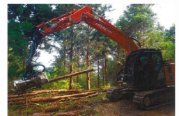
写真-7 プロセッサでの造材状況
