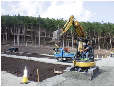
路盤工の施工状況
