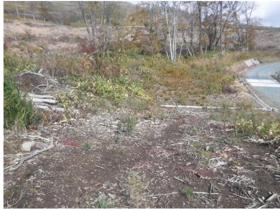
写真-3.54 土場 1 の切土のり面 (粘性土)
