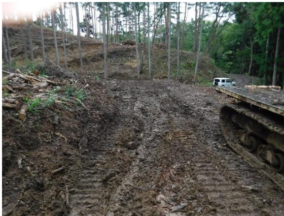
写真-3.65 土場切土のり面
