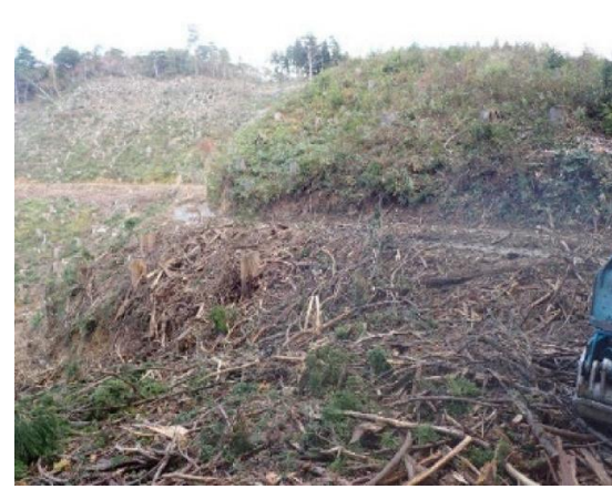
写真-3.8 主伐後の状況
