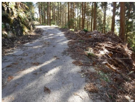
写真-3.102 作業場所 2
