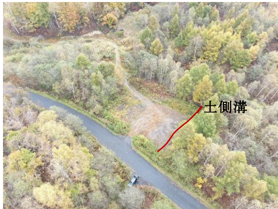
写真-3.35 市道に隣接した土場
