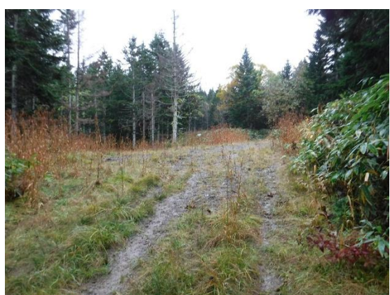
写真-3.29 土場 1 と森林作業道
