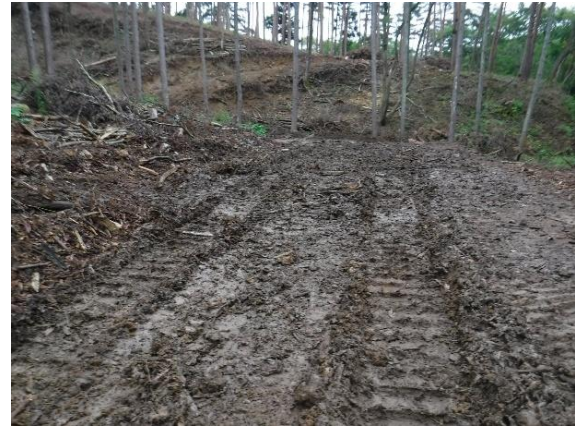
写真-3.64 土場の土質（粘性土） 泥濘化している
