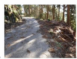
写真-5 作業場所4
