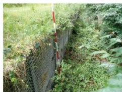
谷側のL型擁壁 (鋼製、施工後10年)
