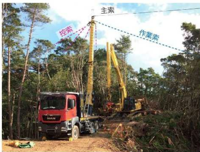
タワーヤードの設置状況 (写真提供: 前田商行株式会社)
