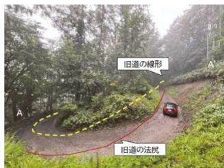
ヘアピンカーブの改築
