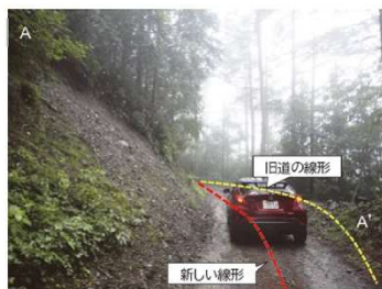
盛土が困難なため山側を掘削してカーブを調整した例
