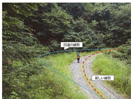
半径12mに改築したカーブ
