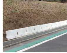
法面からの小落石や防草対策のため土留工を設置（宮崎県日之影町）
