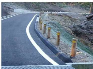
視線誘導柱（新潟県東蒲原郡阿賀町）
