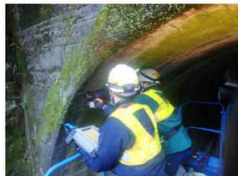
電磁波レーダーを用いた林道トンネル点検
