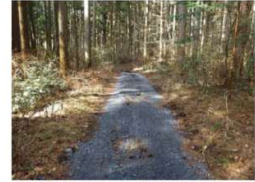
森林組合が管理する林道について、路面補修工事の補助等を実施（栃木県日光市）
