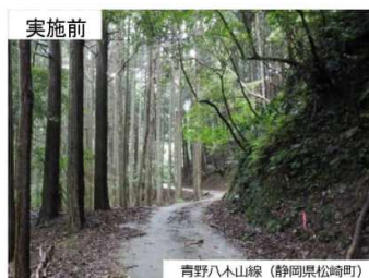
改築前 全幅員3.0m ガードレール等交通安全施設なし
