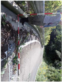
遮水用の高さ18cmの縁石や途中の欄干工により路面水を排水
