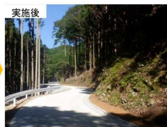
改築後 全幅員4.0m コンクリート路面工、ガードレールを施工 木材の効率的な搬出を実施
