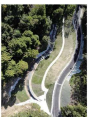
復旧完了後 (R1.10月) (写真提供：飯塚市)
