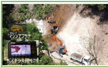
ICT法面掘削機による作業状況 通常のMGV 鈗村も併用
