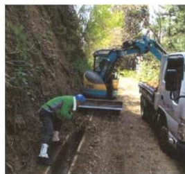
側溝の土砂除去作業
