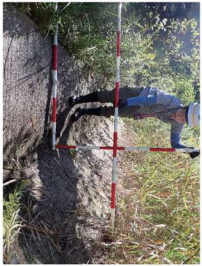
小段に打設したコンクリート（簡易水路）
