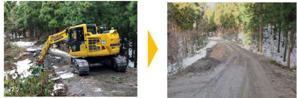
能登半島地震により通行不能となった道路の代替路としての林道の活用(輪島市・林道小池線を仮復旧し通行確保)
