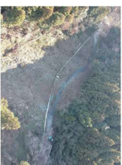
被災状況 (H30.7月)
