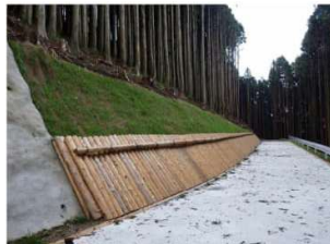
丸太伏工（徳島県勝浦郡上勝町）
