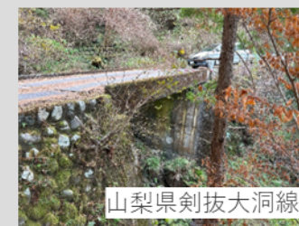
山梨県剣抜大洞線 耐荷重が不足する橋梁では重機を一度降ろし、自走させる必要がある
