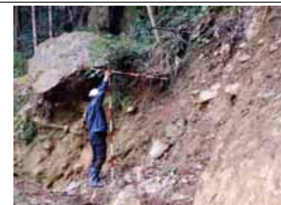
写真② 崩壊地源頭部の滑落崖の状況
