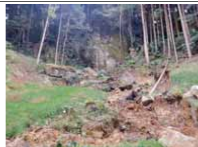
写真③ 崩壊地源頭部の状況（巨石、露岩）
