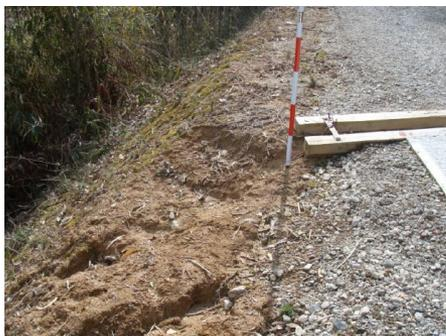
写真 流末処理をしなかったため、のり面侵食が発生した例
