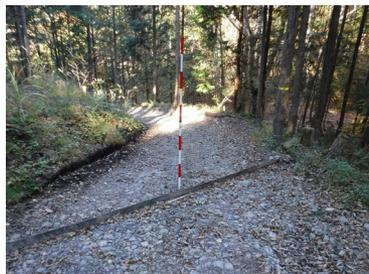
写真 曲線部手前での排水の例
