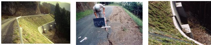
林道の盛土基礎部に構造物(擁壁)を設置した例
