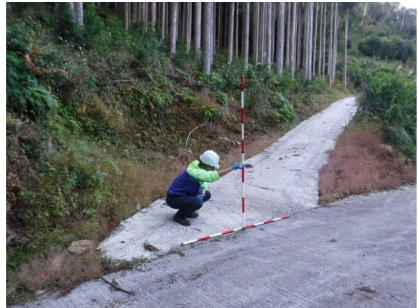
写真-2.44 コンクリート路面工の状況
