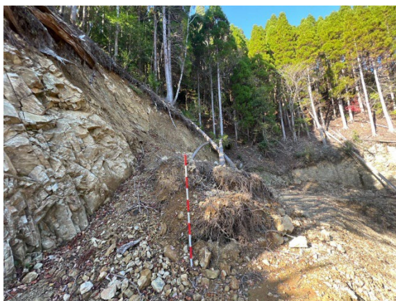
写真-2.87 切土崩壊の状況
