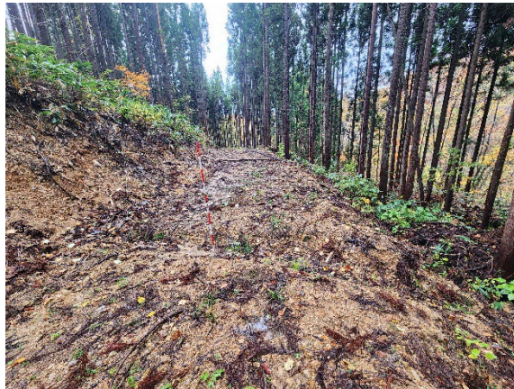
写真-2.4 素掘り横断溝の状況 (山一作-04)
