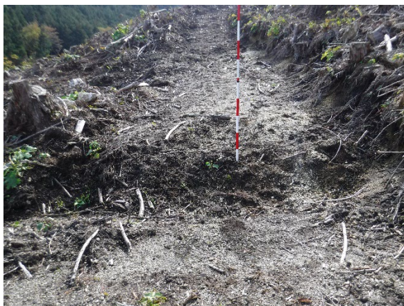
写真-2.30 素掘り横断溝の状況
