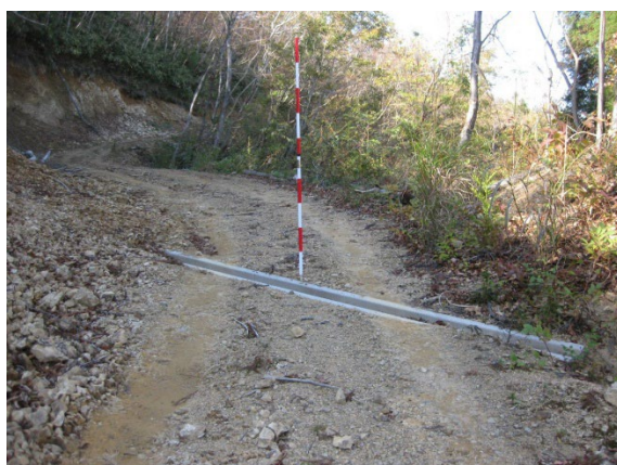
写真-2.100 コンクリート横断溝の状況
