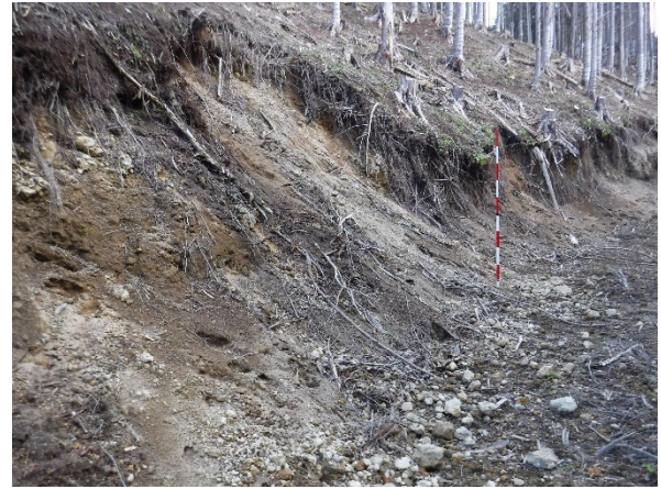
写真-2. 42 切土崩壊の状況（軽石層）
