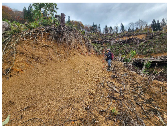
写真-2. 24 切土崩壊の状況
