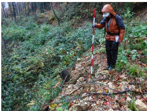
写真-2.15 路肩崩壊の状況
