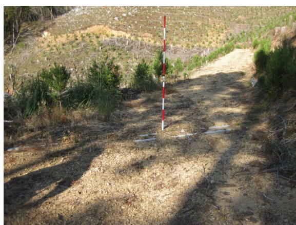
写真-2.95 コンクリート横断溝閉塞の状況
