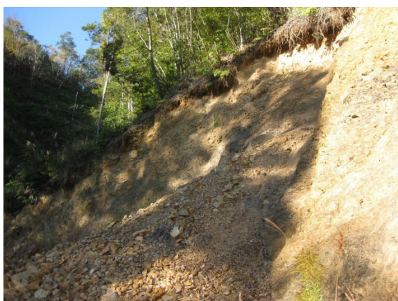
写真-2.93 山腹崩壊の状況
