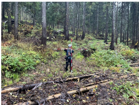
写真-2.3 丸太横断排水溝の状況 (山一作-01)
