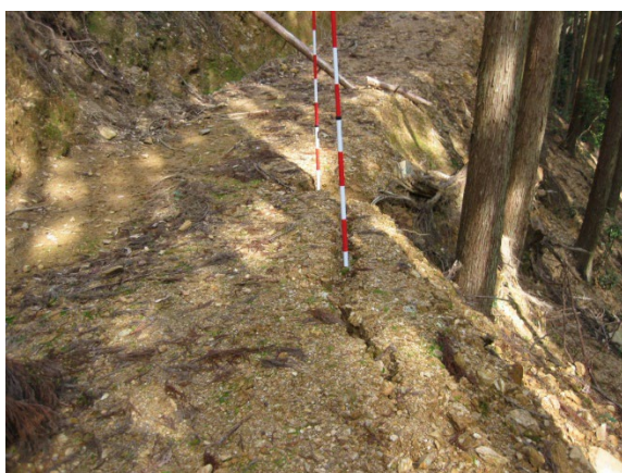
写真-2.75 クラックの状況
