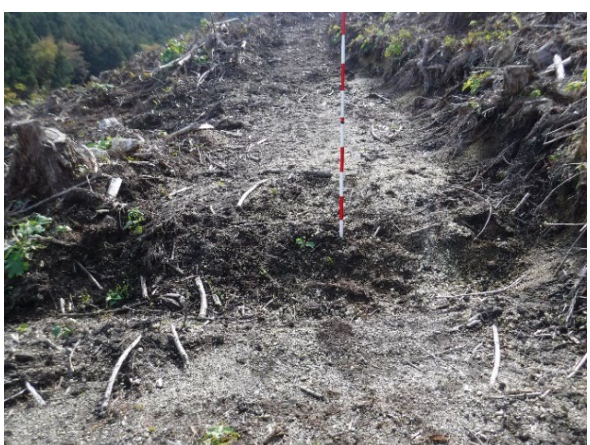
写真-2.8 素掘り横断溝の状況 (群一作-01)
