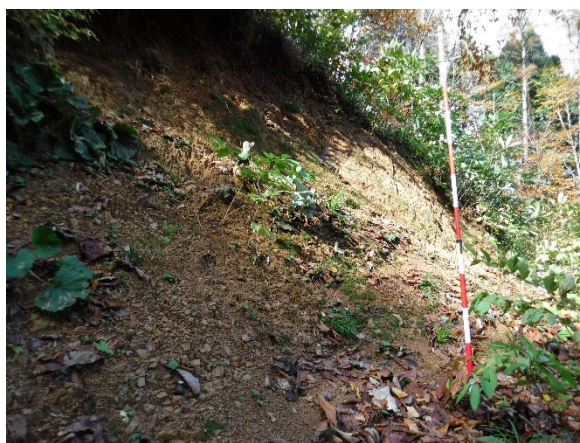
写真-2.20 切土崩壊の状況
