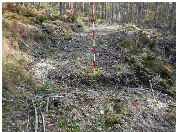
写真-2. 38 素掘り横断溝の状況
