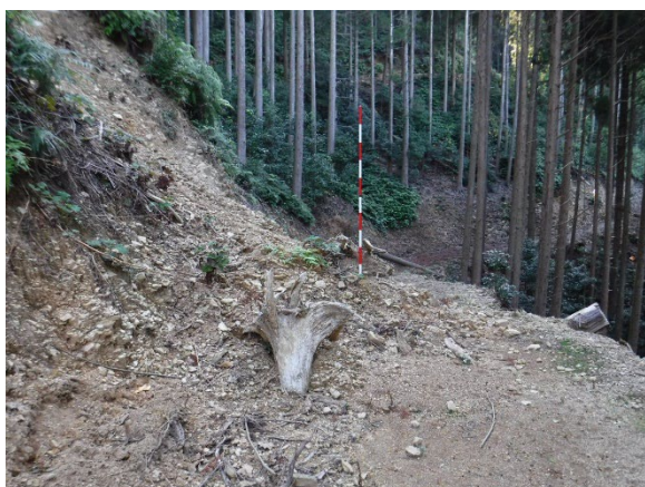
写真-2.49 切土崩壊の状況
