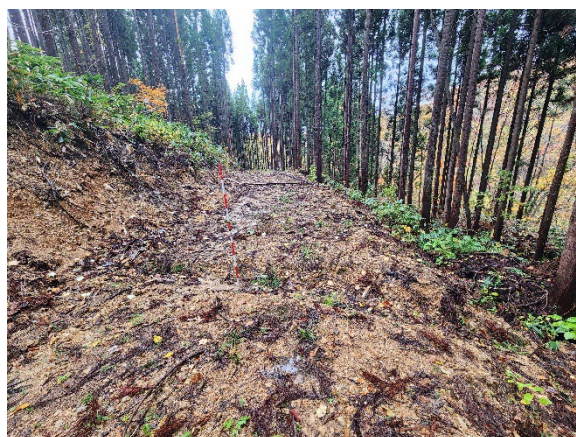
写真-2. 26 素掘り横断溝の状況
