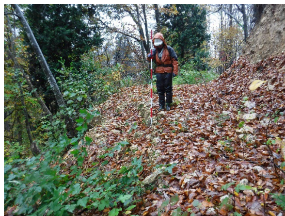
写真-2.16 路肩崩壊の状況
