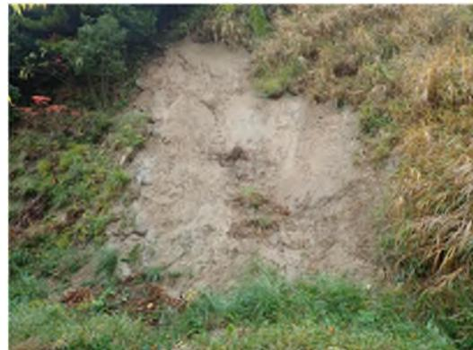
写真 3.2.46 法面崩壊状況（現状）
