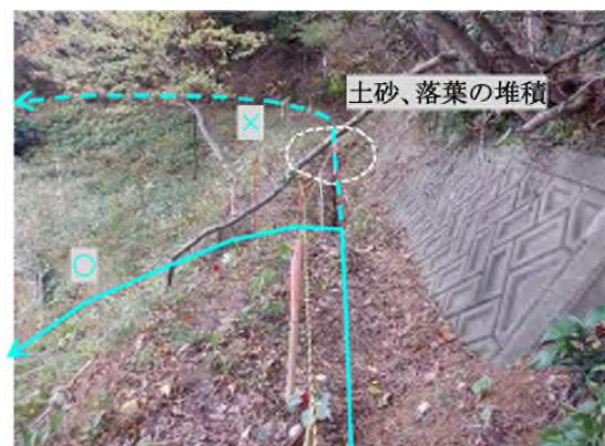
写真 3.2.10 U型側溝の土砂・落葉堆積状況
