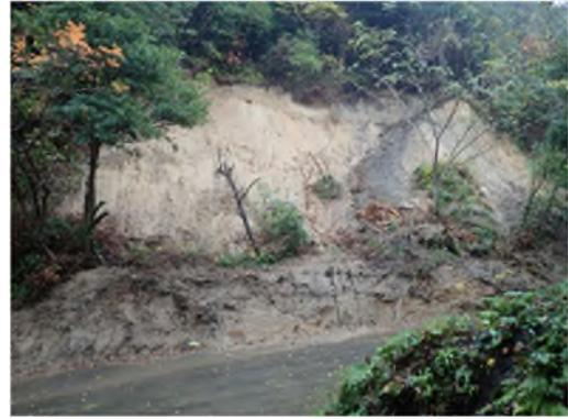
写真 3.2.54 法面崩壊状況(被災当時)
