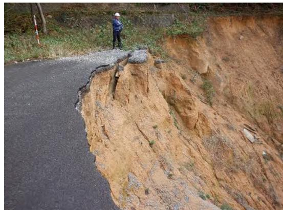
写真 3.2.2 崩壊源頭部の状況
