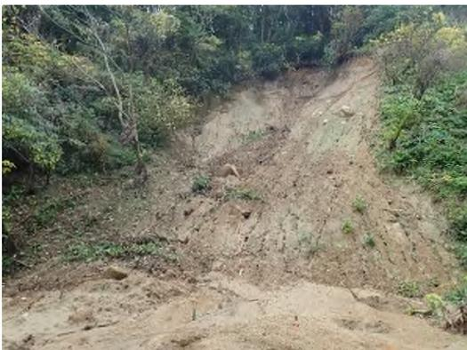
写真 3.2.43 法面崩壊状況(1) (現状)
