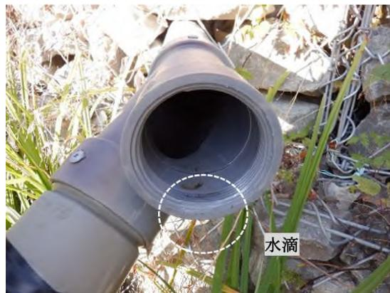
写真 3.2.13 1号ボーリング暗渠工流末 写真 3.2.14 2号ボーリング暗渠工孔内
