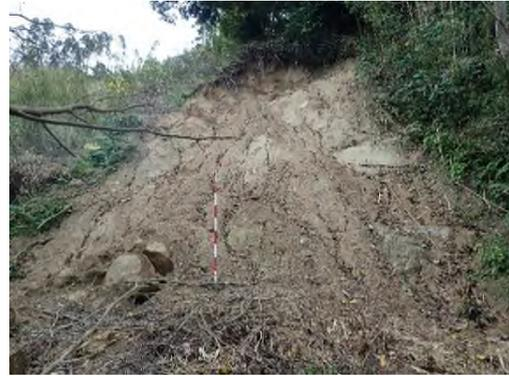
写真 3.2.34 法面崩壊状況(現状)
