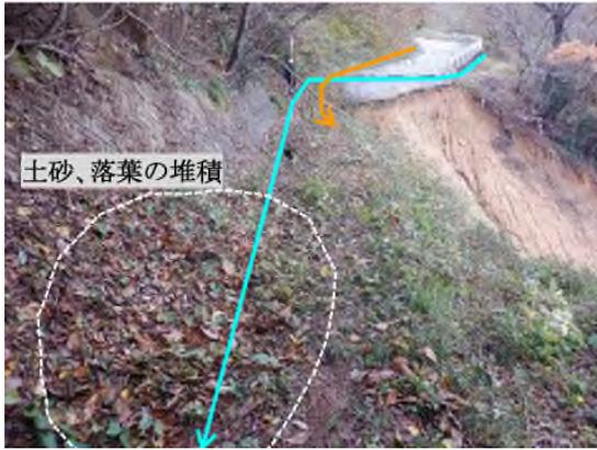
写真 3.2.7 被災箇所頭部の排水路
