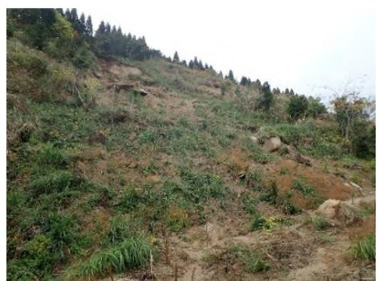
写真 3.2.44 法面崩壊状況(2) (現状)
