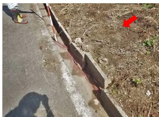
写真 3.2.11 路肩の隆起 (被災当時) 写真 3.2.12 山側水路の変状 (被災当時)
