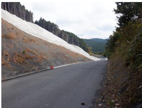
写真 3.2.21 モルタル吹付工(起点側)
