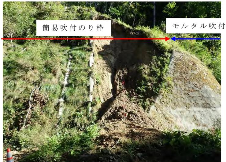
図 3.2.67 構造物配置状況
