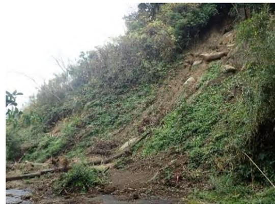
写真 3.2.40 法面崩壊状況(現状)
