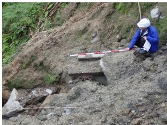
写真 3.2.32 流末処理された L 型側溝
