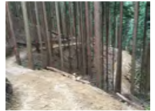
緩勾配で作設された道
