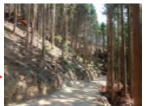
伐開幅を最小限にし道際の木も残した作業道
