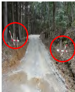
施工の目印となる 丁張りの設置
