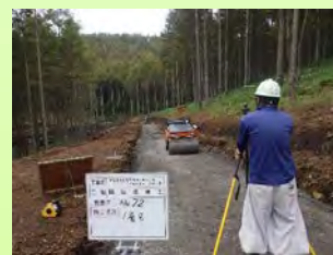
自動追尾型トータルステーションを利用した 施工基面の高さ確認状況
