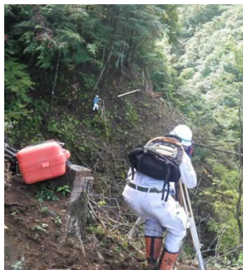
急傾斜地での測量
