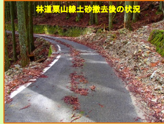
林道栗山線土砂撤去後の状況
