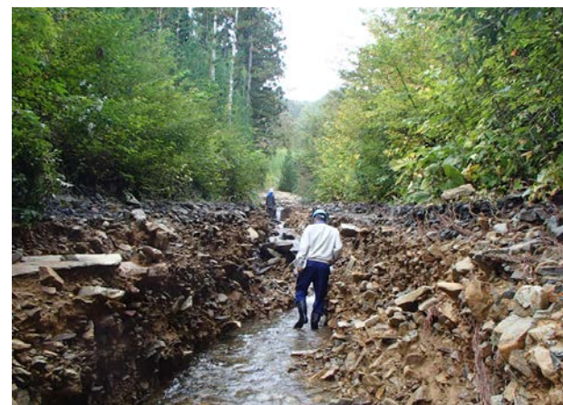
令和元年東日本台風 (岩手県山田町)
