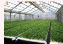
農業生産施設（水耕栽培ハウス）
