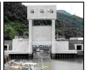
津波・高潮対策としての水門整備
