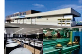
集出荷・貯蔵・加工施設
