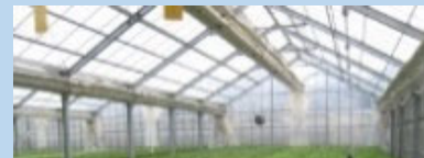
障害者等が作業に携わる生産施設の整備
