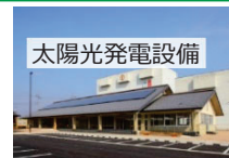
太陽光発電設備
