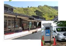
EV車等への給電設備
