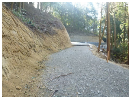
（森林作業道整備）
