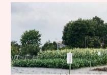
園地、園路整備
