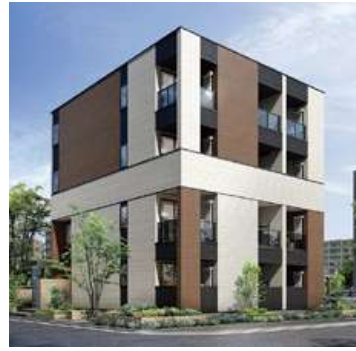
CLT(直交集成板)を用いた木造4階建ての集合住宅 (温室効果ガス排出の削減や工期短縮の効果)
