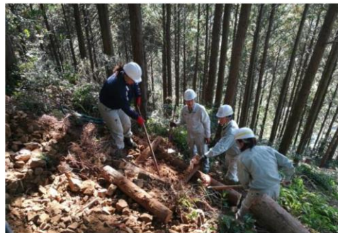
作業道路整備研修「木組み補強」の様子
