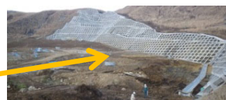
法枠工による山腹対策
