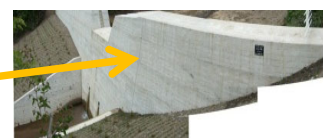
治山ダムによる溪間対策
