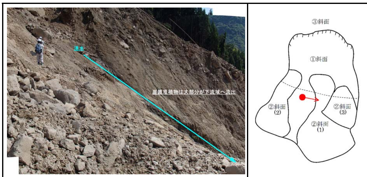
写真9 “②斜面(1)” 崖錐堆積物流出後の上部斜面の状況
