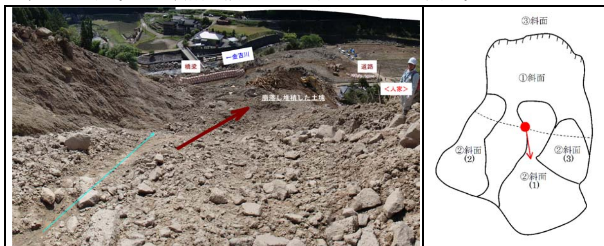
写真10 “②斜面(1)” 下部崩落土塊堆積状況
