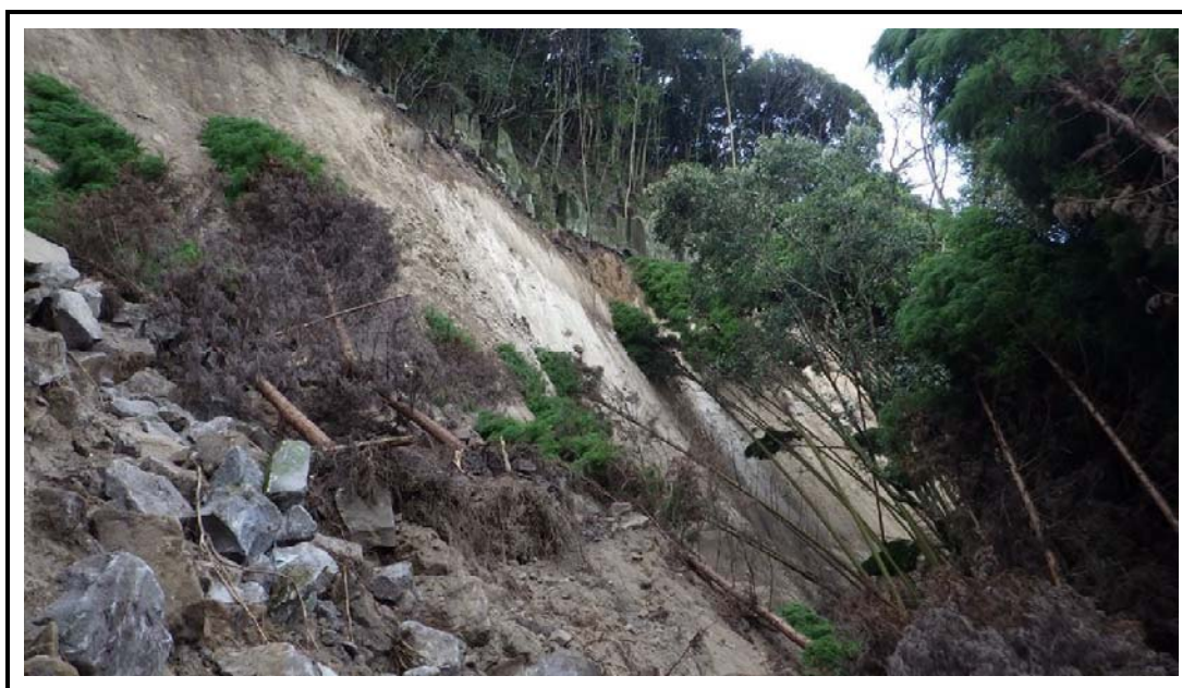
写真4 頭部滑落崖の状況<4/12撮影>
