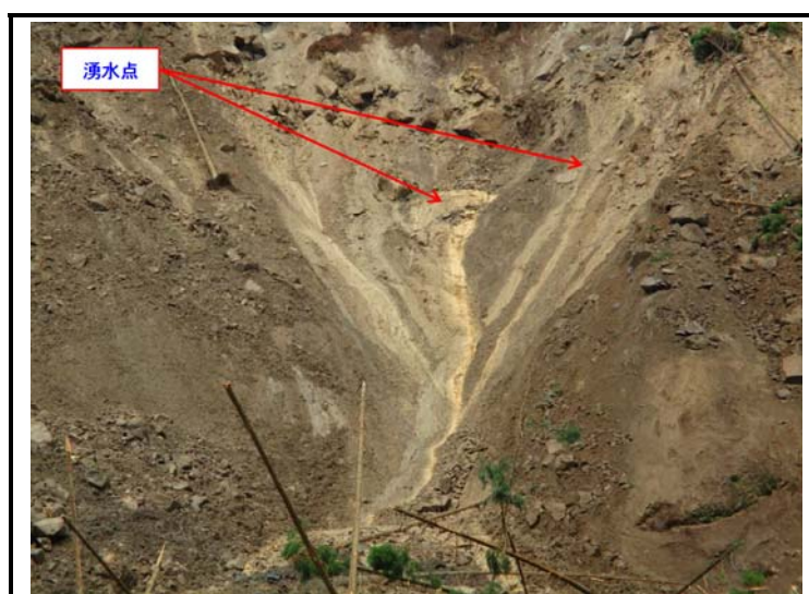
写真3 UAVによる崩壊斜面中腹部“湧水点”の近接写真
