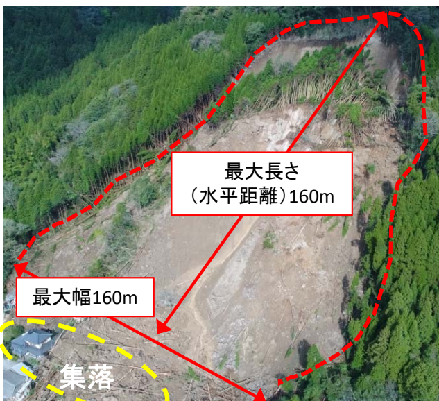
最大幅160m、最大長さ160mの範囲で崩落
