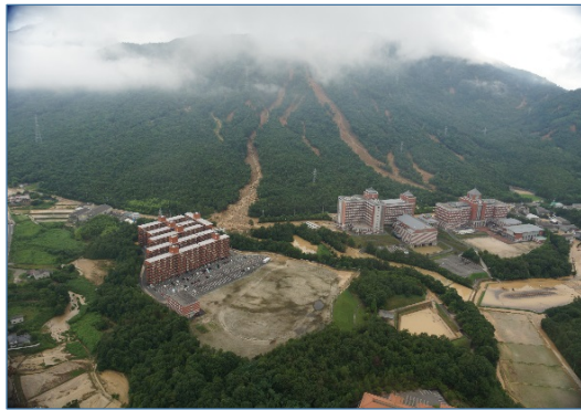
東広島市黒瀬の山腹崩壊状況
