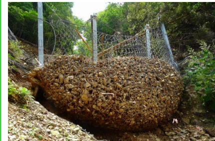
(参考)ワイヤーネットの施工箇所による土石・流木捕捉の例
