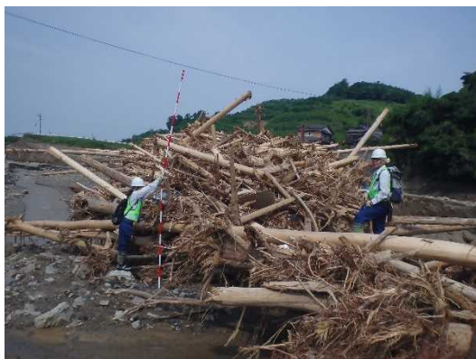
奈良ヶ谷川(朝倉市)の流木堆積状況
