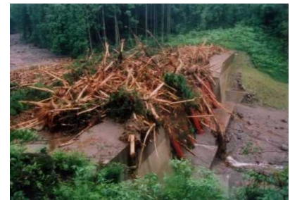
流木捕捉式治山ダム
