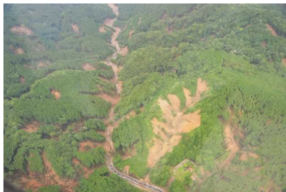
奈良ヶ谷川(朝倉市)の山腹崩壊状況
